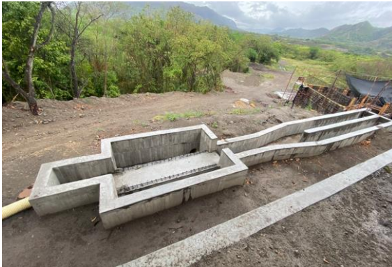
NP 2.2 Suministro e instalación de concreto impermeabilizado relación A/C = 0.40
