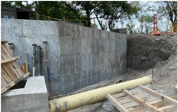
NP 2.1 Muro de contención en concreto 3.000 PSI, H=2.0 M
