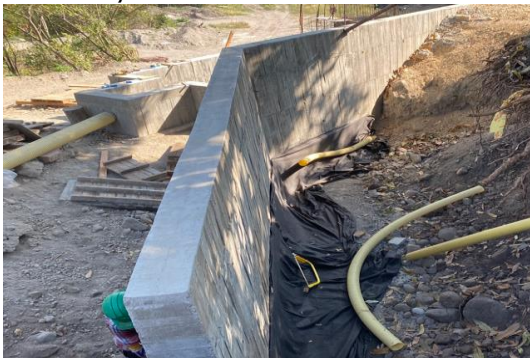
NP 2.1 Muro de contención en concreto 3.000 PSI, H=2.0 M
