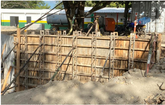
NP 2.2 Suministro e instalación de concreto impermeabilizado relación A/C = 0.40
